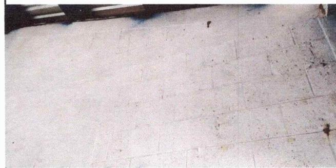
Foto 10: Se observa el color en pesima condicion y muy deteriorada. MODULO 3
