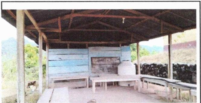
Foto1: El piso de la cocina deteriorada, las maderas y ventanas en mal estado. Modulo 1
