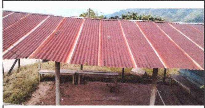
Foto 4: Se observa el techo de la cocina deteriorada y oxidada. MODULO 1
