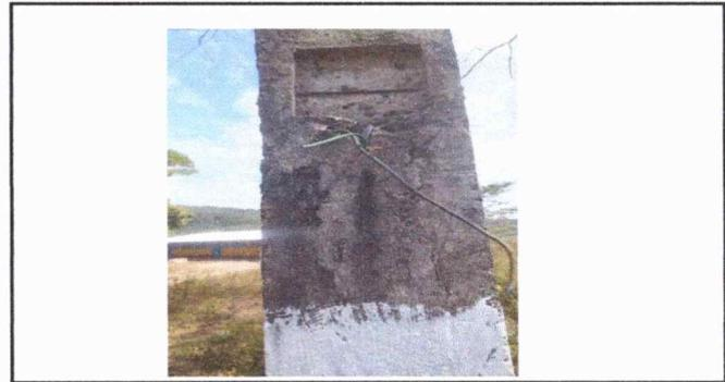
Foto 6: Se encuentra el poste de base del contador pero hace falta cableados. MODULO 2
