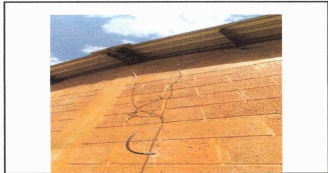
Foto 5: Se observa el cable incompleto en la instalacion de la escuela, falta conexión eléctrico. MODULO 2
