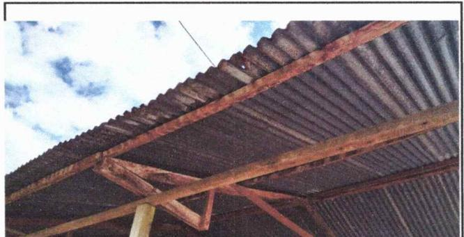
Foto 2: Las costaneras y las estructuras generales se observa deteriorada. MODULO 1
