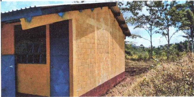
Foto7: Se observa el deterioro de la pintura y pálida de color de la escuela No. 3. MODULO 3
