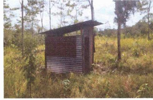
Foto 12: Se observa deteriorada las laminas y puertas. MODULO 4
